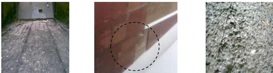
Рис. 1. Деградация бетона боковых стен ГХ УСК КРК «Ангара» в процессе модернизации (реконструкции)
